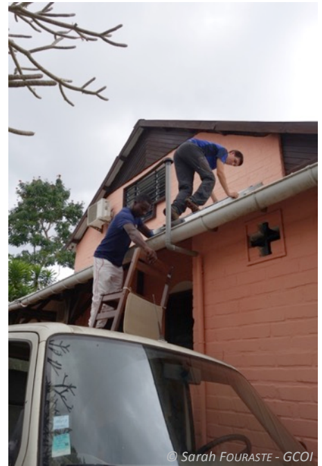
Pose du thermo-bouton dans la toiture des locaux de l'ONF - Coconi
